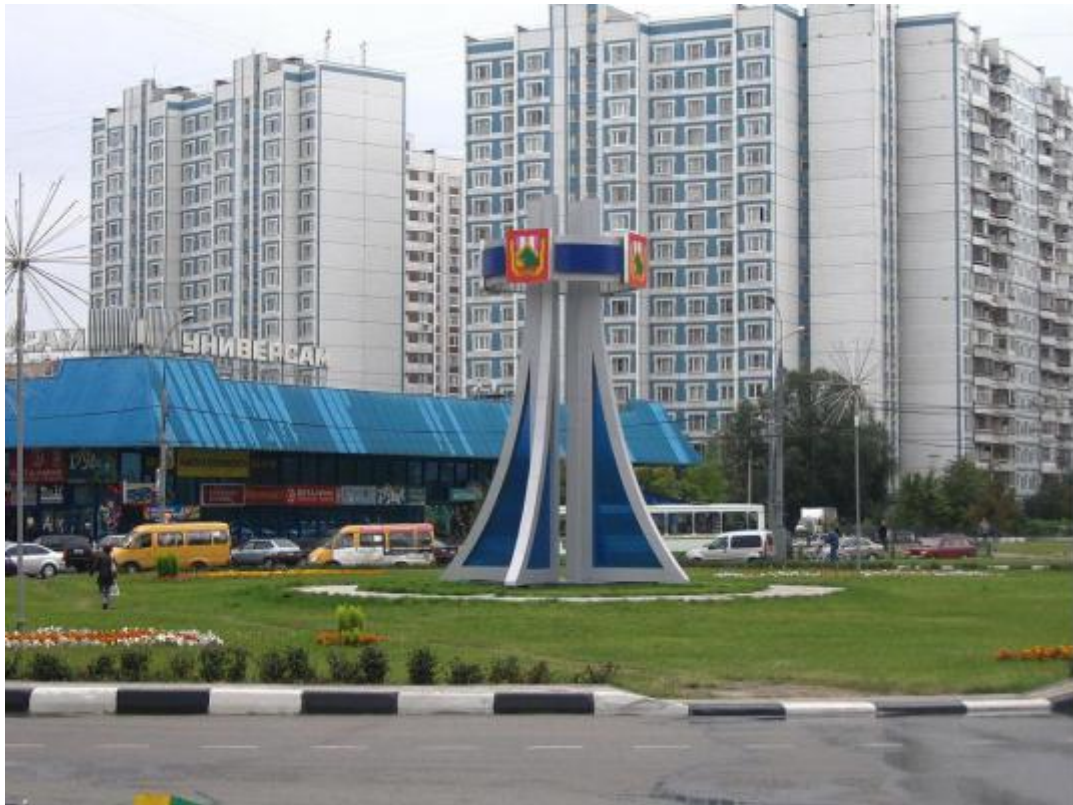
Figure 4. Immeubles P44 à Moscou Source: Vidal-Giraud, 2017
