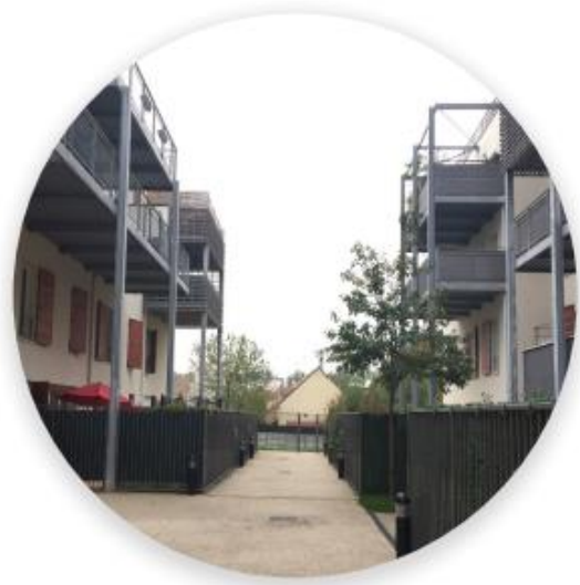
Fig. 4 : Résidence Ballastière Sud Îlot 4 – LIMEIL-BREVANNES
