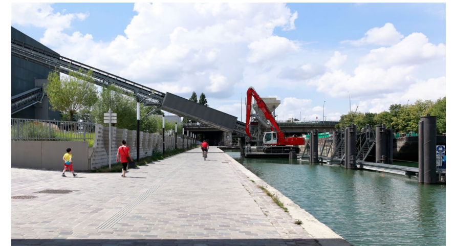
Continuités piétonnes et cyclables, Port Serrurier
