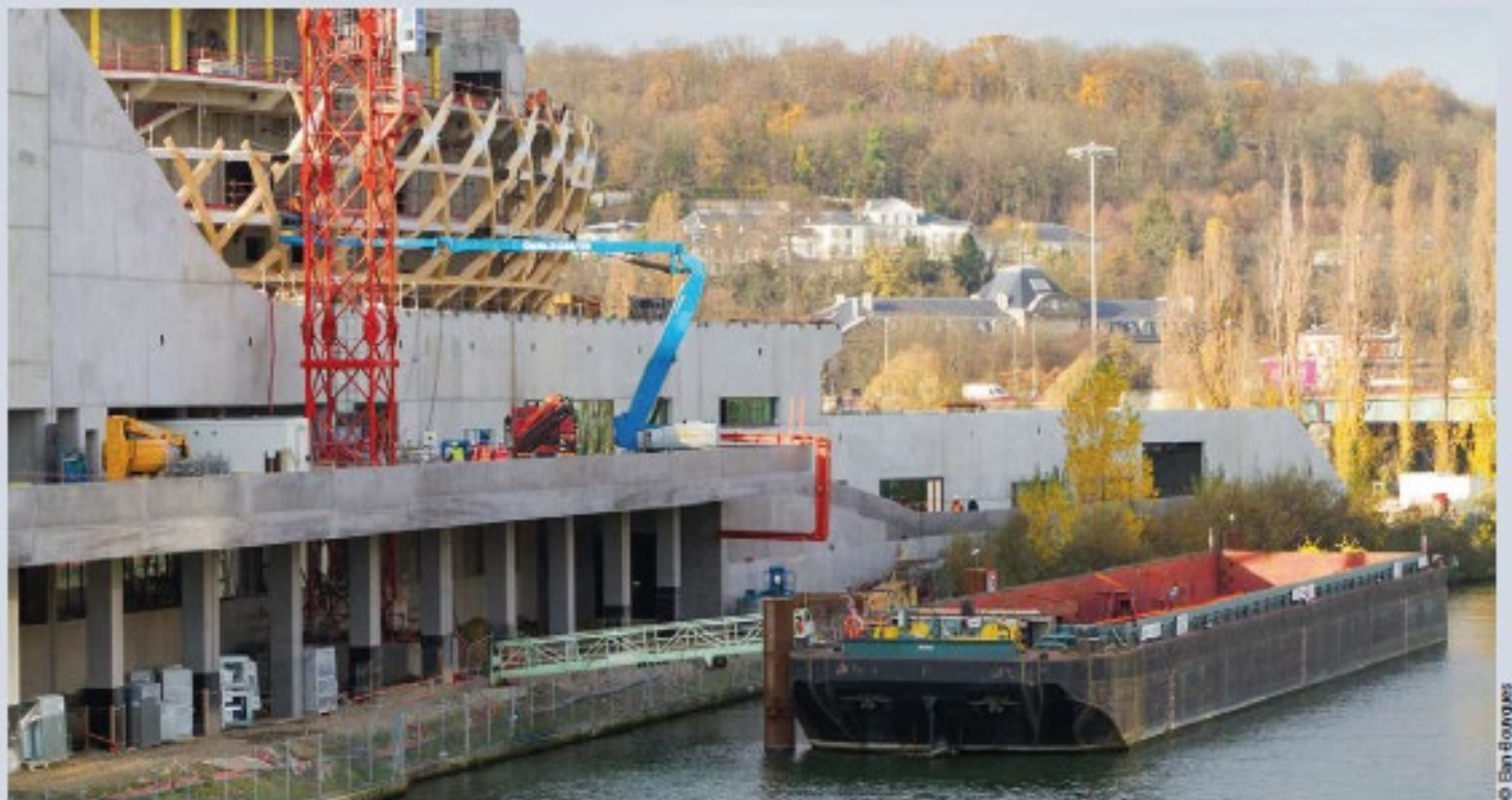
La barge le long du chantier de la Seine Musicale
