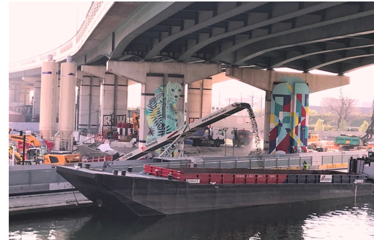
Evacuation des terres de déblais pour les chantiers du GPE, près de 45 millions de tonnes devront être évacuées.
