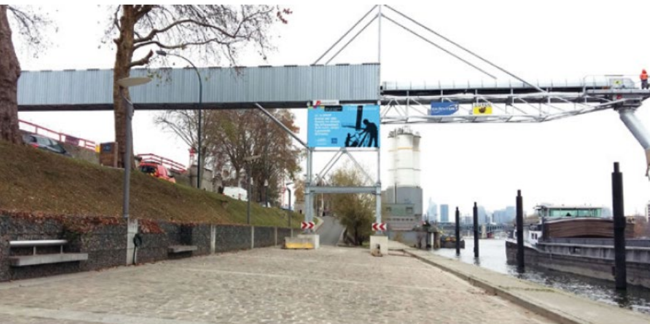
Evacuation des déblais par convoyeur à bande franchissant la RD1
