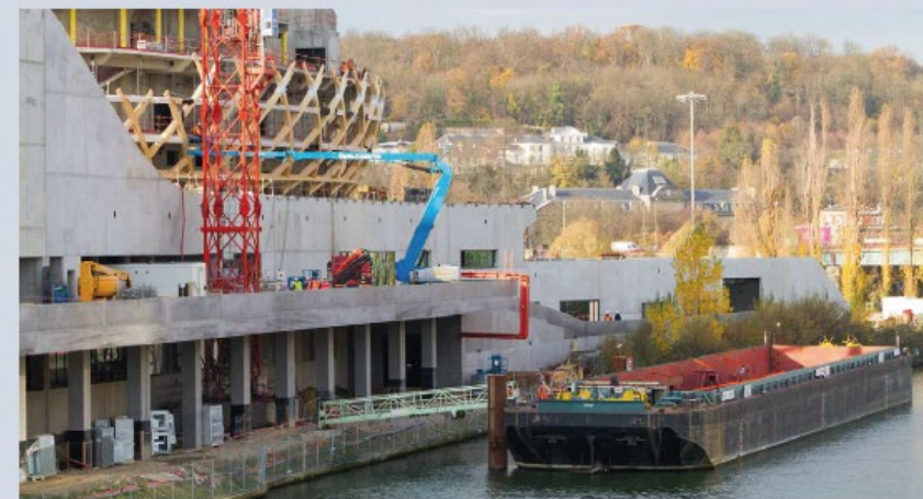
La barge le long du chantier de la Seine Musicale
