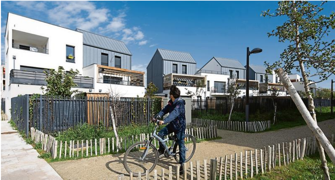
Dans l'écoquartier Les Roseaux, à Montévrain en Seine-et-Marne, un développement mené à bien par EpaMarne aujourd'hui réalisé aux deux tiers. Epamarne/Architecte : Atelier BLM/photo : Emile Luider
